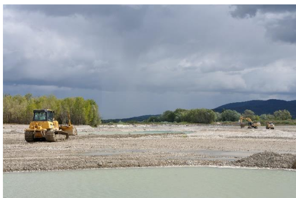
Photo n°6 : Dragage piège à graviers de la Drôme
