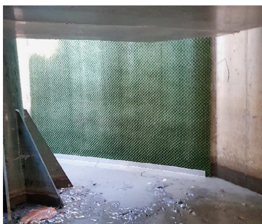
Mise en place du géotextile (vue de l'intérieur du puit) ©Photo de l'entreprise Rampa
